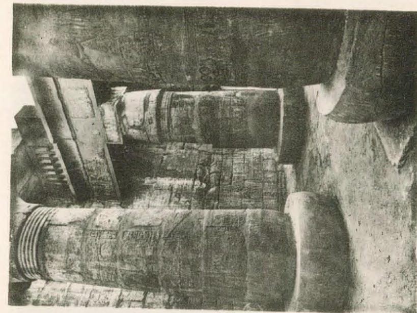
Temple de Khonsou. — Salle Hypostyle, côté Ouest. Dalle de plafond, corniche et architrave redressés et consolidés; fenêtre à claustra reconstituée.
